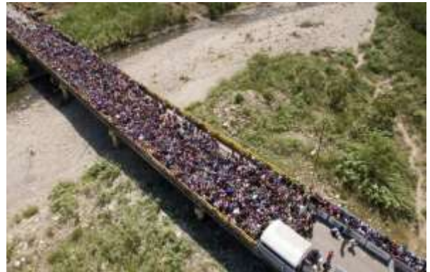
Internationale Brücke zwischen Venezuela und Kolumbien in Cúcuta mit Flüchtlingsstrom nach Kolumbien. Quelle: El Tiempo, Foto von Juan Pablo Cohen
